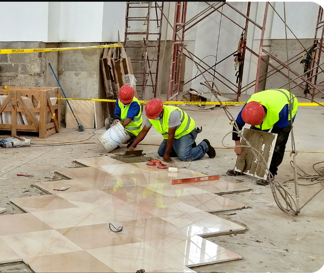
INSTALACIÓN DE PISOS
