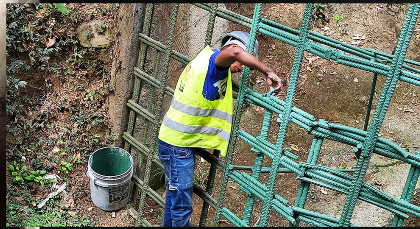
MANTENIMIENTO DE ALCANTARILLADO DE RÍO Y TUBERÍAS EN CONDOMINIOS
