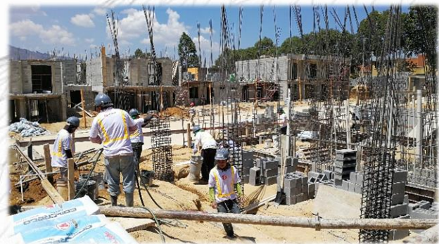
Levantamiento de obra gris (fundiciones y tabicaciones con mampostería)
