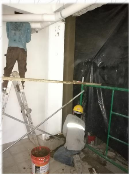
Levantamiento de obra gris (fundiciones y tabicaciones con mampostería)
