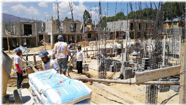
Levantamiento de obra gris (fundiciones y tabicaciones con mampostería)
