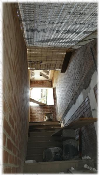
Levantamiento de obra gris (fundiciones y tabicaciones con mampostería)
