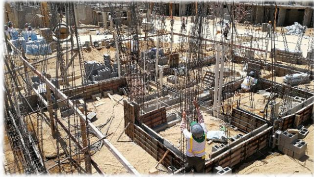
Levantamiento de obra gris (fundiciones y tabicaciones con mampostería)
